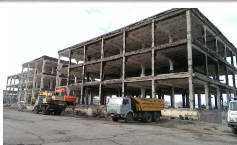
Состояние фундаментов, каркаса здания и перекрытий – работоспособное, деформаций и повреждений не обнаружено.
